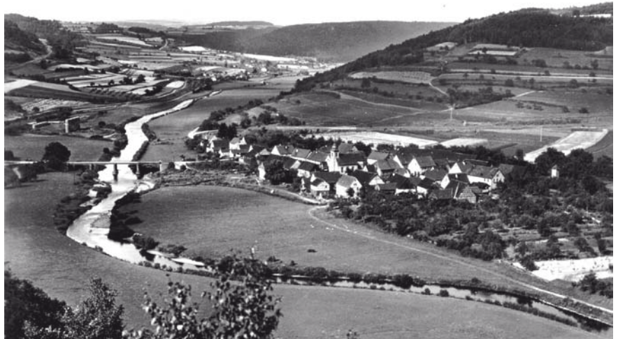
Abbildung 134: Brückenbaustelle Bw 144 mit Gräfendorfer Hang
